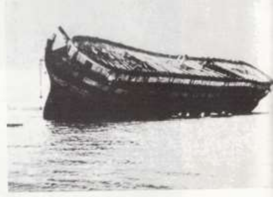
L'épave du Borda , en cours de démolition.
