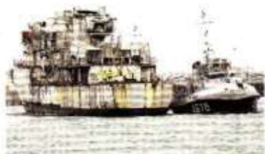
Les démolisseurs ont fait leur œuvre sur le coque du avis-aviso.
